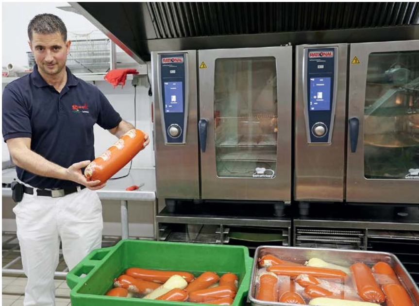
Thomas Eisele legt beim Lastmanagement Hand an, um den Grad der Selbstversorgung noch zu steigern. Die Kombidämpfer startet er erst nach Sonnenaufgang per Timer.
