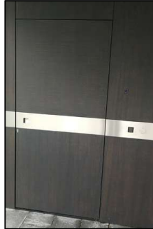
Bild 2: Kaum zu erkennen, rechts neben der Tür, oberhalb des Metallbands: Der Fingerabdruck-Sensor, mit dem sich die Tür öffnet – aber nur mit Strom
