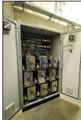
**Bild 2:** Der Pacadu-gesteuerte Stromspeicher im Technikraum des energetisch optimierten Gebäudes speichert den überschüssigen Solarstrom
