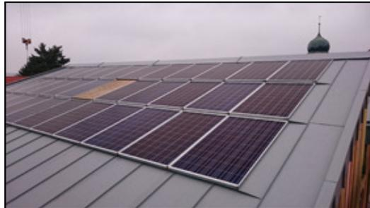
**Bild 4:** Das einzige System, das es nicht auf dem Markt gab, entwickelten die Rupp-Brüder selbst und haben es mittlerweile patentiert: Die PV-Anlage als In-Dach- und gleichzeitig Kombi-Lösung, die sowohl Strom als auch Wärme produziert
