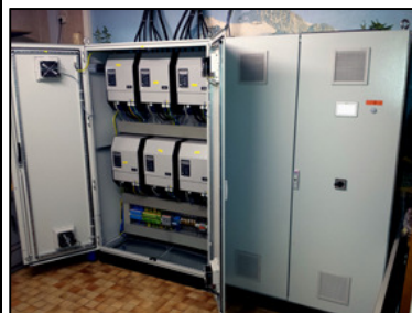
Bild 6: Der geöffnete ASD-Wechselrichterschrank mit 6 Batteriewechselrichtern mit jeweils 6 kW Leistung.
