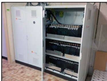
Bild 5: Die ASD-Batteriezellen im geöffneten Batterieschrank
