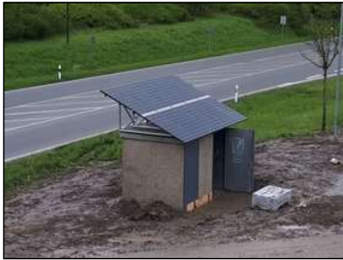
Bild 1: Die Baustelle im Jahr 2017: Das Häuschen, in dem sich der Stromspeicher des Typs Pacadu Flex befindet und auf dessen Dach die PV-Anlage montiert ist, musste platzsparend gebaut werden
