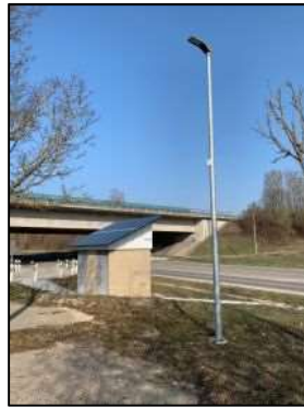
Bild 2: Der Parkplatz Mitte März 2019: Das System überbrückt lichtarme Zeiten; bei geringem Ladestand drosselt es selbstständig die Leistung und warnt den Betreiber
