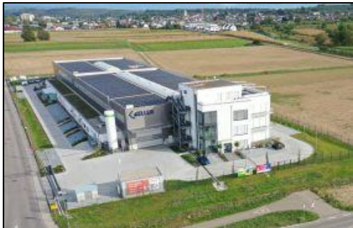
Bild 1: Eine Luftbildaufnahme des Neubaus von Keller Blechtechnik: Auf dem Dach die 563 kWp-PV-Anlage und im kleinen Gebäude vorne links ist der Pacadu-Speicher untergebracht.
