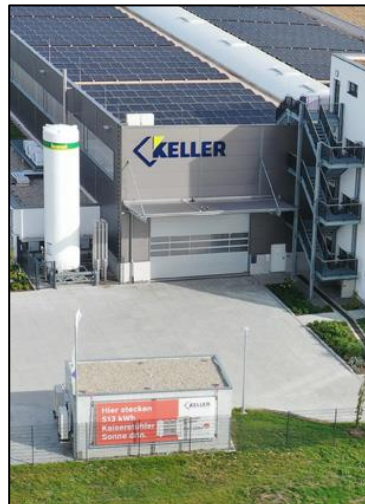
Bild 2: Keller Blechtechnik hat den Pacadu-Speicher in einem kleinen Extra-Gebäude untergebracht. Die Aufschrift – gut sichtbar für die vorbeiführende Landstraße: „Hier stecken 513 kWh Kaiserstühler Sonne drin“.
