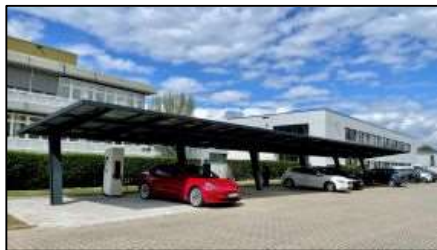
Bild 1: Der Solarcarport der 1st Flow Energy Solutions GmbH schließt Stromtankstelle samt -speicher mit ein.
